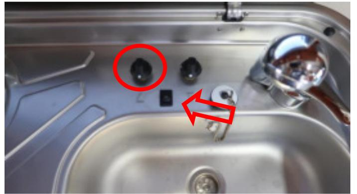
レバーを押して回しながら、スイッチを押して点火します。
