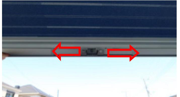
先端部分に足が収納されています。指で矢印の方向に押しとロックが解除できます。
