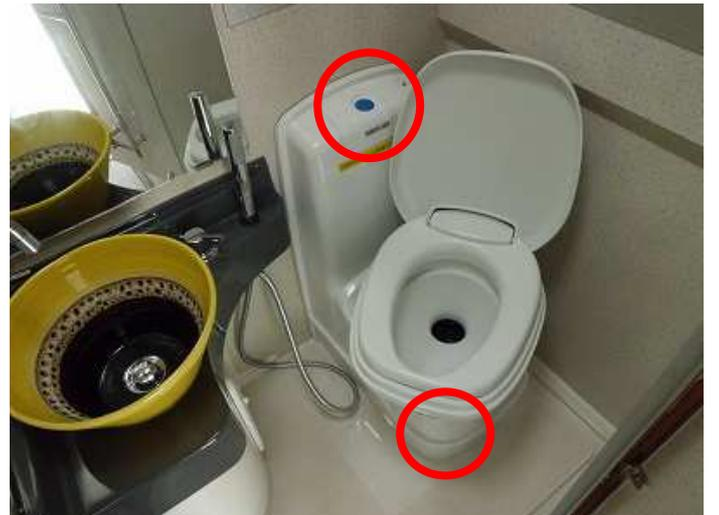
用を足す前にタンクのボタンを1回押します。使用後便座下のレバーを開いて流します。最後にタンクのボタンを押して洗浄液を流します。
