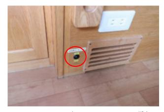
インバーターはサブバッテリーの 12V 電気を 100V 家庭用の電気に変える機器です。コンセントを使うときに ON。
