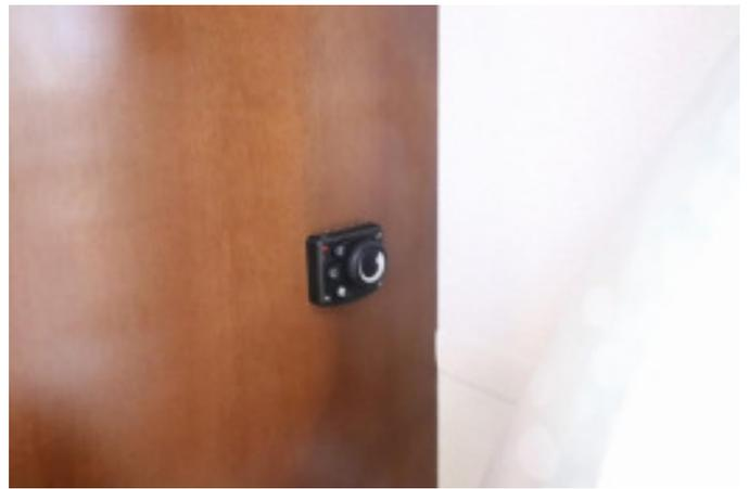
左上のボタンが ON、左真ん中のボタンが OFF、左下のボタンが送風、右のダイヤルが温度調節。
